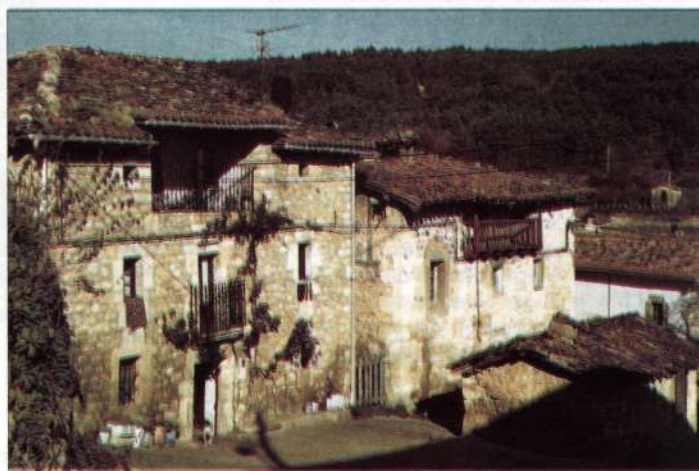
Tobillas conserva dentro de su caserío la forma típica de construcción del valle de Valdegovía, donde destaca la balconada superior
