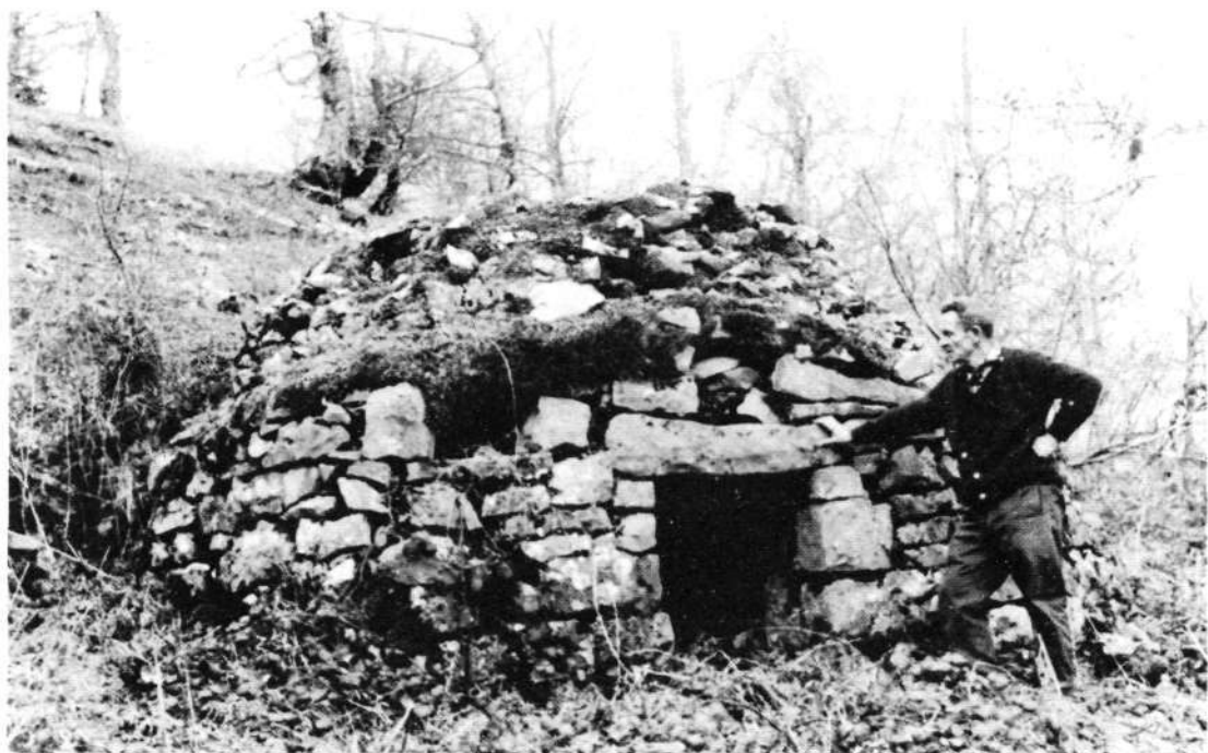
FOTO 2. Txabola de planta circular y falsa bóveda hemisférica en Domingonekoa, en el monte Insausti de la Sierra de Aralar navarra. Se les denomina «arkoak», «arkuak» o «arkupe».
