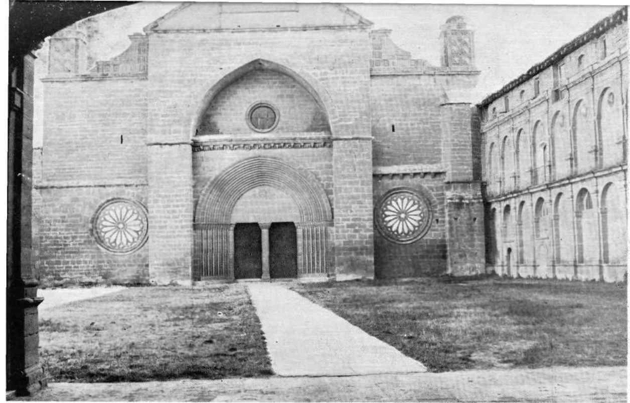
Fachada principal del Monasterio de La Oliva desde el interior del recinto monacal.
