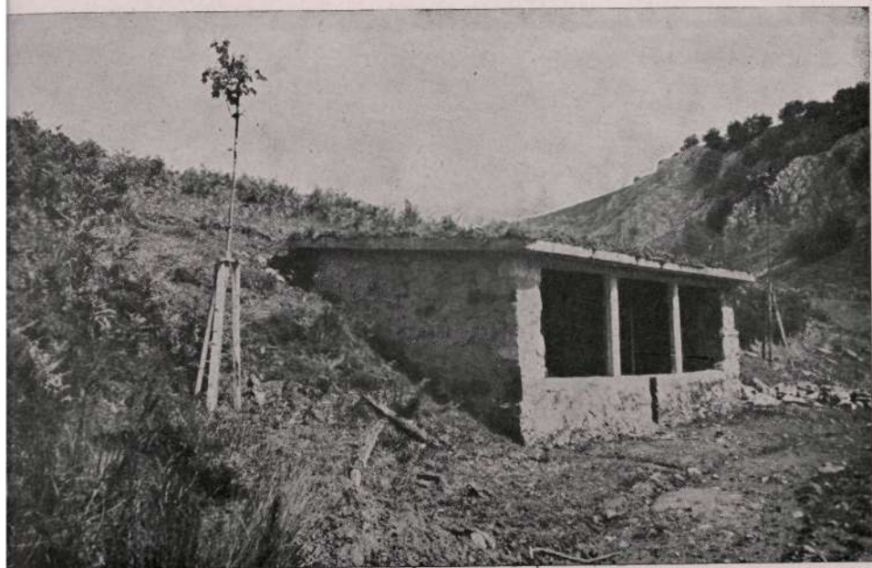
Cobertizo de Asuntze (Amboto), construido en 1952.
