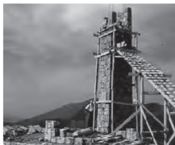
Construcción del monumento de Besaide (Archivo Familia Puoyo)
