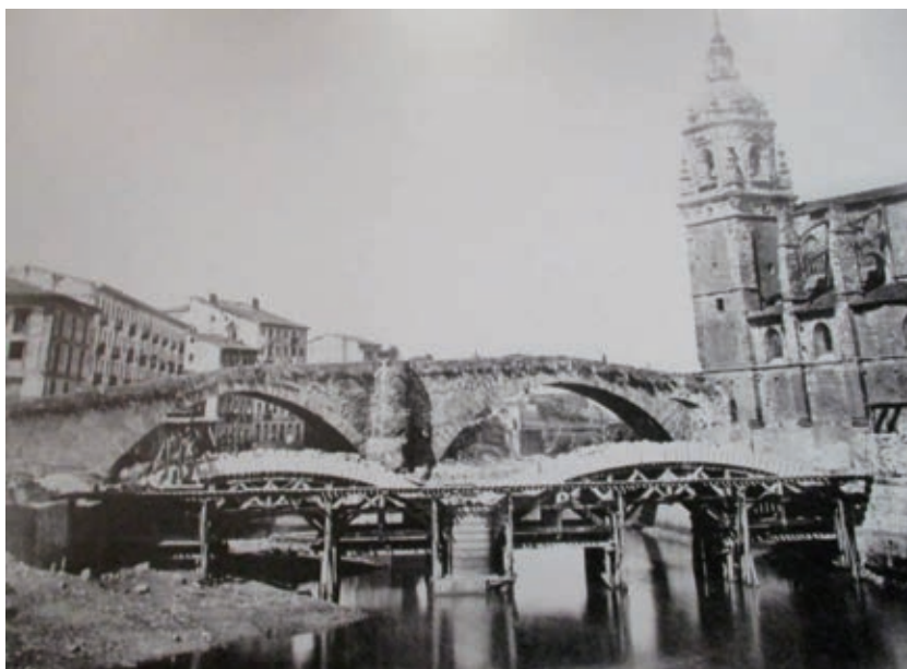
Puente nuevo de San Antón en construcción
