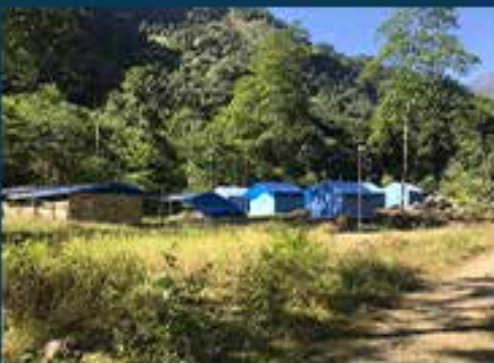
RECONSTRUCCIÓN DE 108 VIVIENDAS TRAS EL MONZÓN
