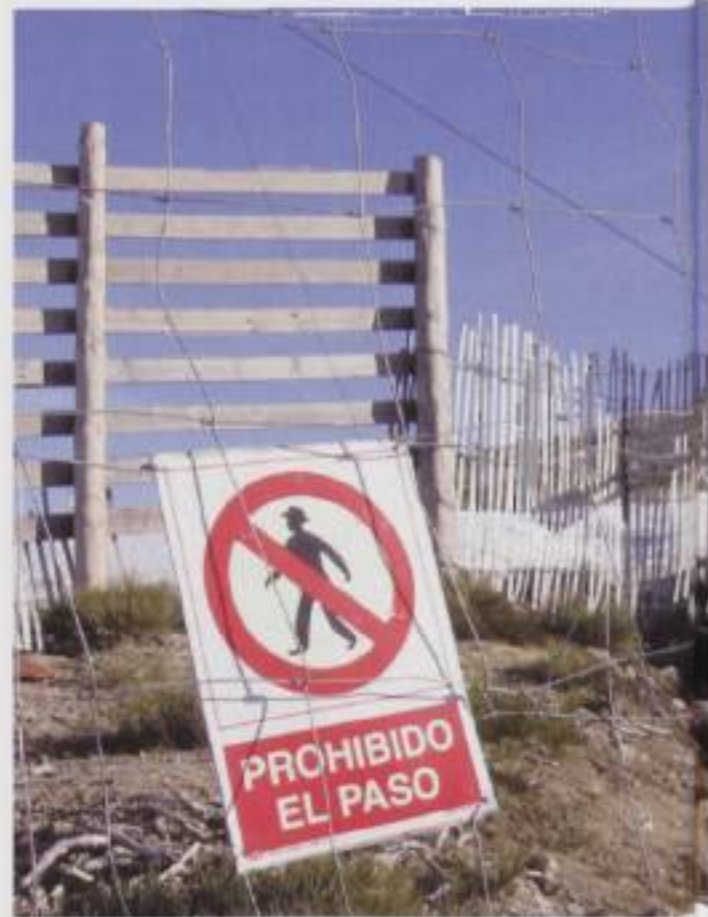
■ Obras de ampliación La Covatilla
