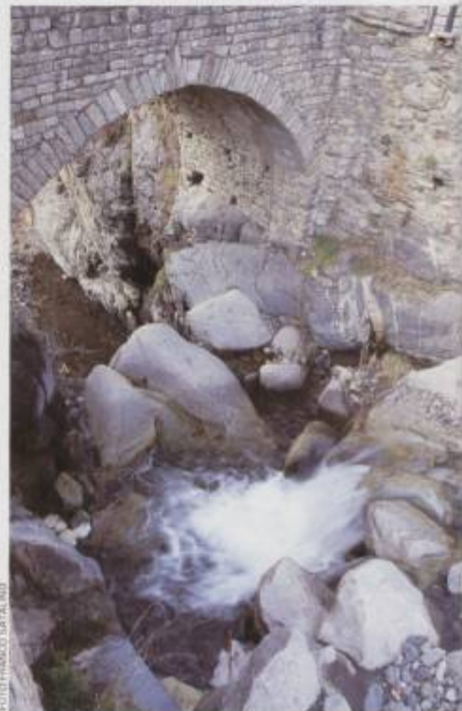
■ Puente románico sobre el río Sant Martí a su paso por Boí
